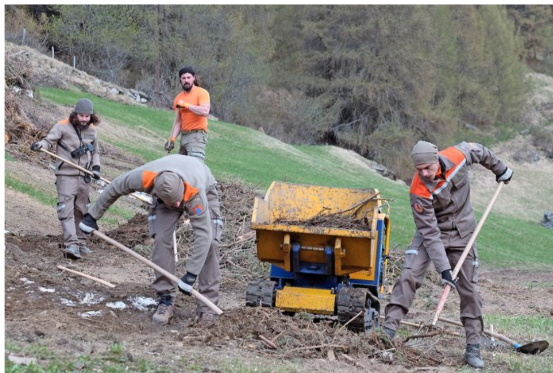
Statt einer Trockenübung konnte die Kompanie zwei der Zivilschutzorganisation Hardwald im Mai einen echten Einsatz leisten. Sie half in Zernez, den Schutt abzutragen, den zwei grosse Lawinen hinterlassen hatten.
